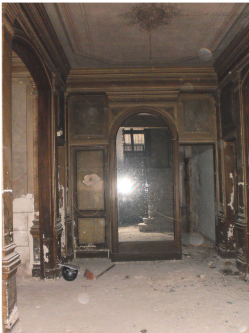
Vue du hall depuis l'escalier principal
