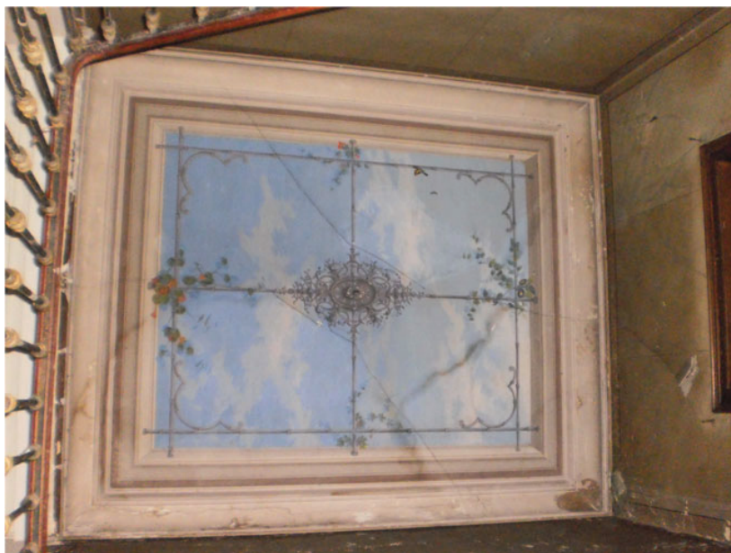
Photo du décor peint au plafond au dessus des escaliers réalisé dans la même esprit que celui du dégagement entre les deux salons : une verrière avec des faux éléments architecturaux de la structure, le ciel et les plantes. Une rosace en stuc moulurée est placée au centre de la « verrière ».
