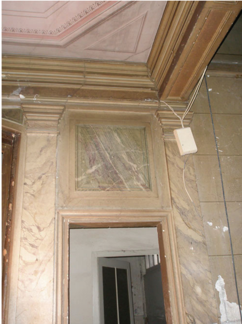
Photo du décor peint des parois du hall montrant le trumeau d'une porte, deux pilastres, le soubassement de la cage de l'escalier et les corniches moulurées.
