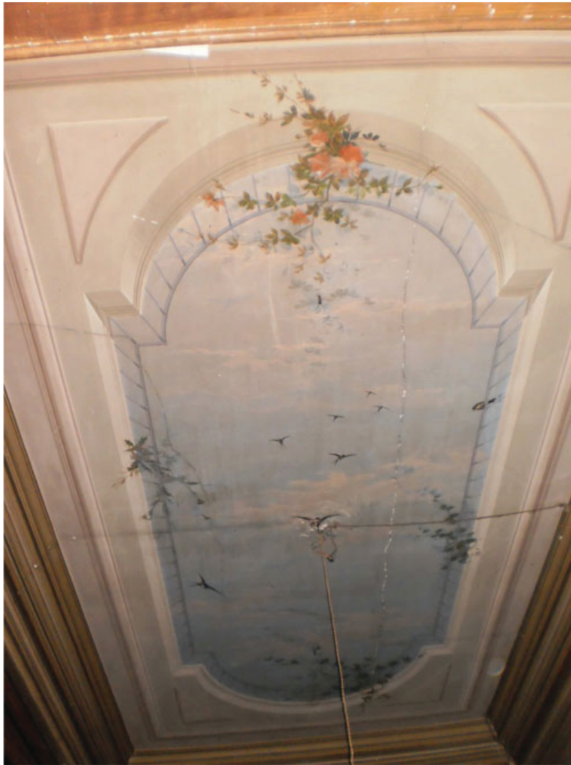
Photo du décor peint au plafond du dégagement entre les deux salons du rez-de-chaussée montrant une fausse verrière dessinée entre les corniches moulurées.
